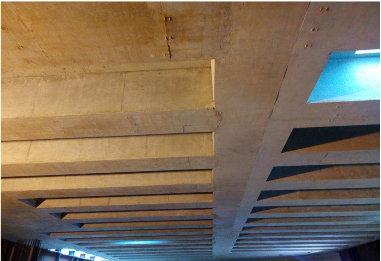
Foto 2 – Interventi di ripristino su solaio Testata Sud
