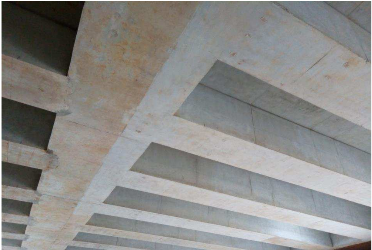
Foto 2 – Interventi di ripristino su solaio Testata Sud
