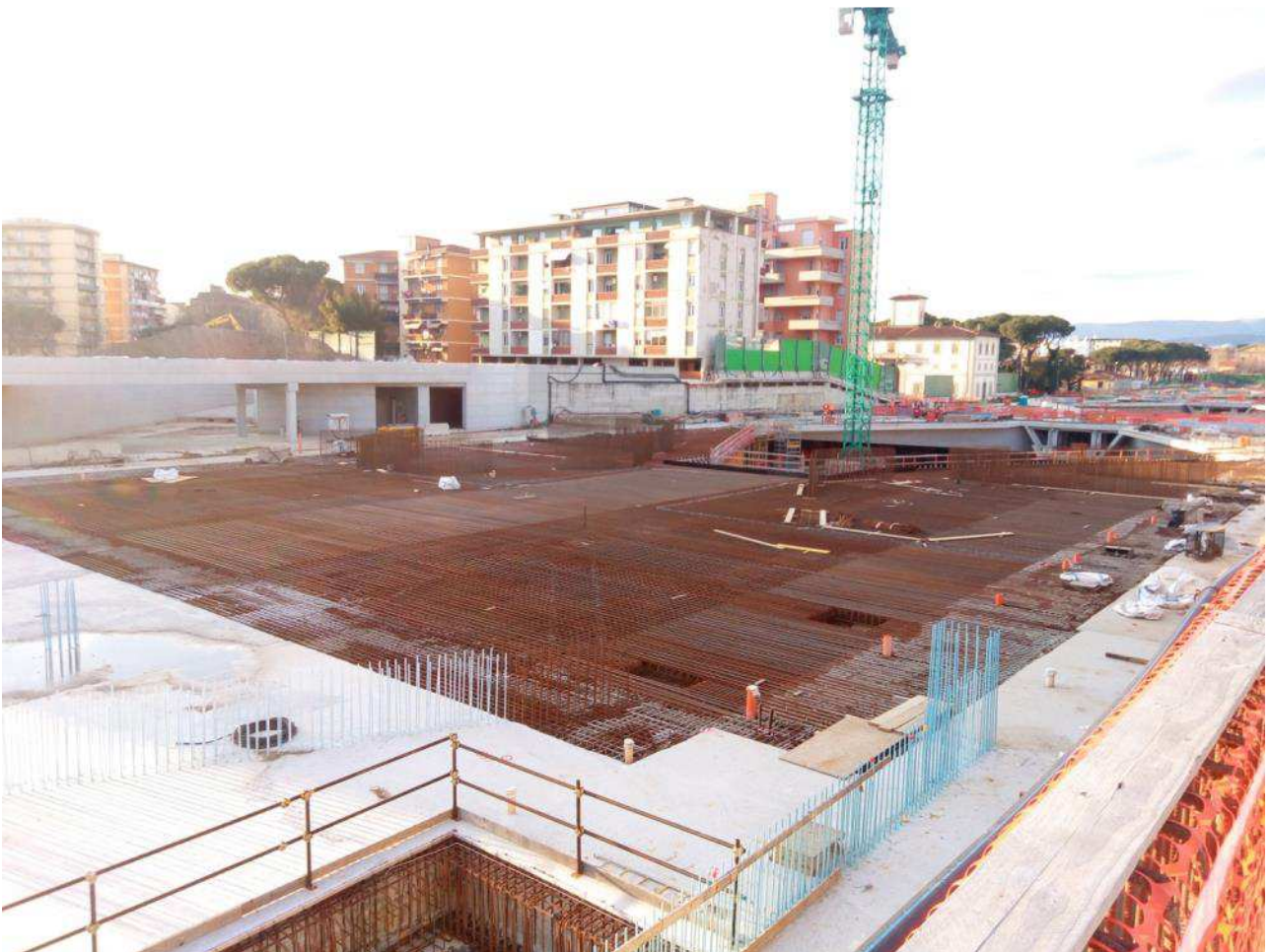
Foto 1 – Posa armatura solaio ventaglio 33
