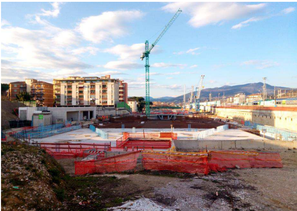
Foto 3 – Panoramica da Sud
