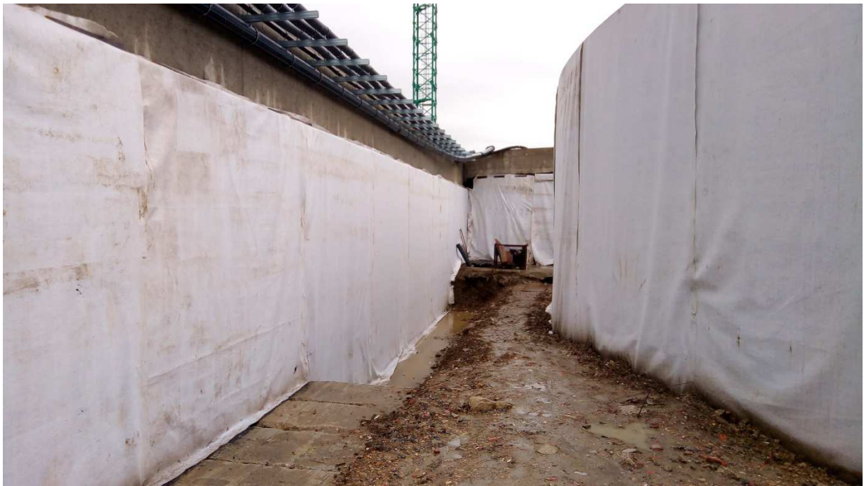
Foto 3 – Impermeabilizzazione muro di confine a tergo rampa Kiss & Ride
