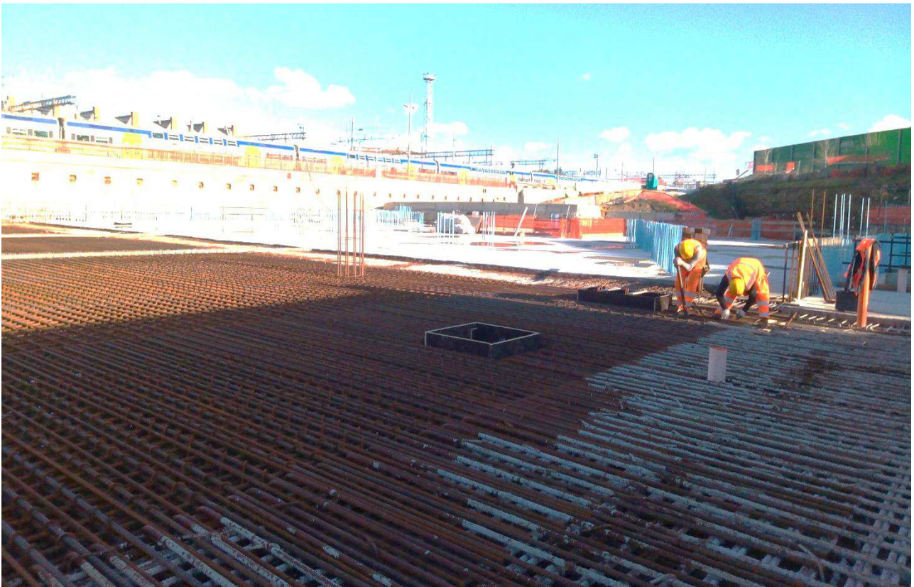
Foto 1 – Posa armatura solaio ventaglio 33
