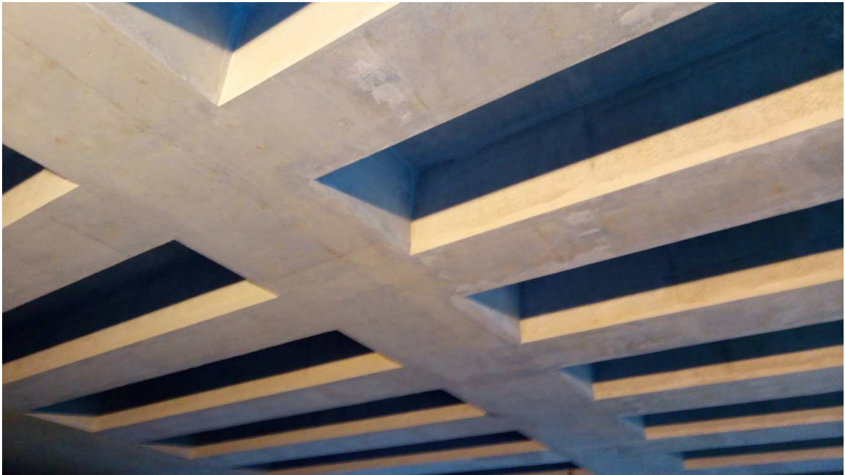
Foto 2 – Interventi di ripristino su solaio Testata Sud
