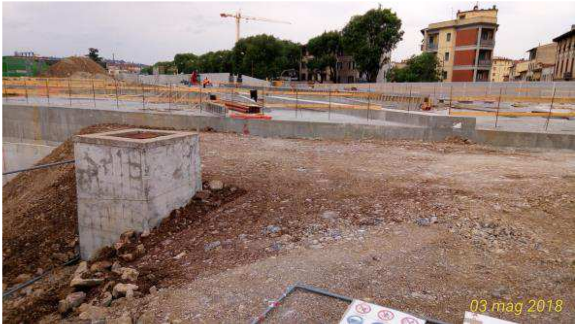
Foto 2 – Completamento rilevato a tergo rampa Kiss & Ride
