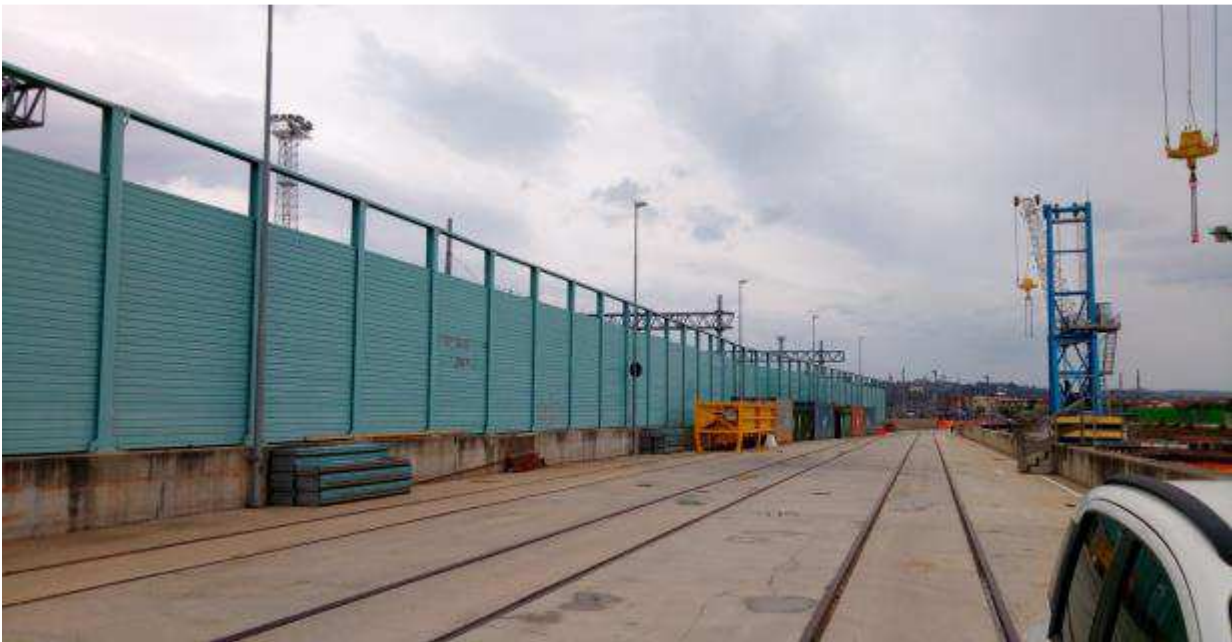
Foto 1 – Messa in sicurezza barriere antirumore corridoio attrezzato
