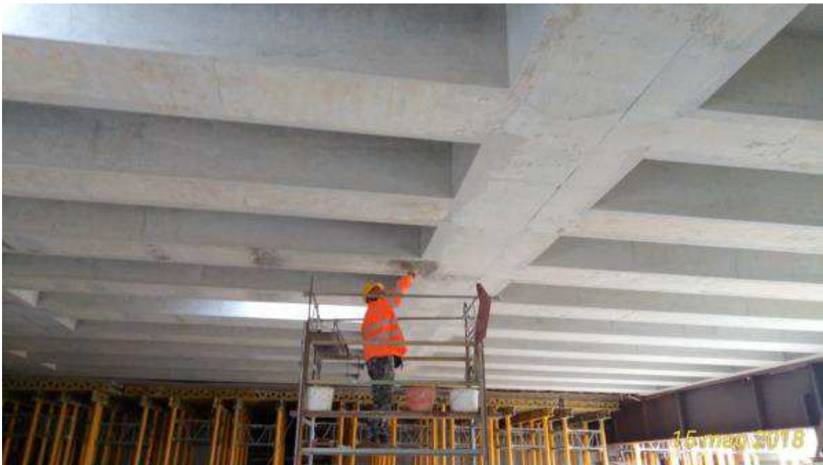
Foto 1 – Interventi di ripristino su solaio Testata Sud
