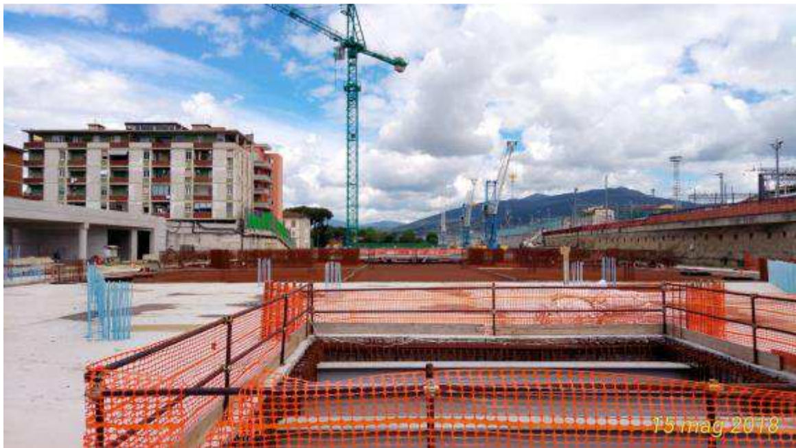
Foto 3 – Panoramica da Sud
