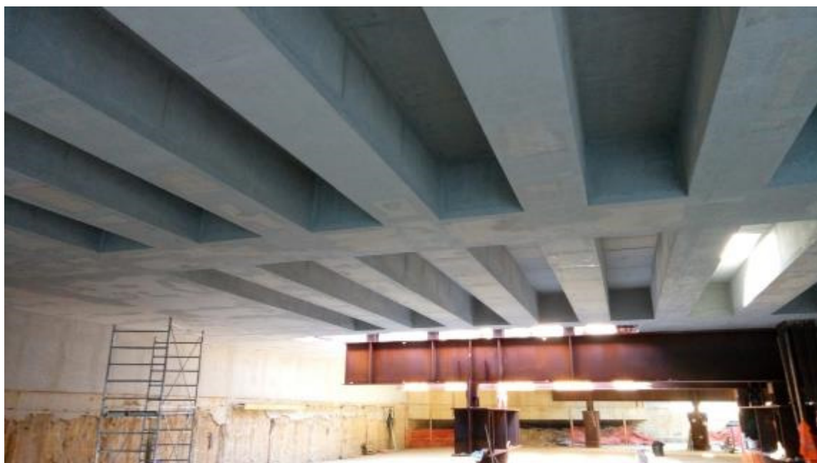
Foto 1 – Interventi di ripristino su solaio Testata Sud
