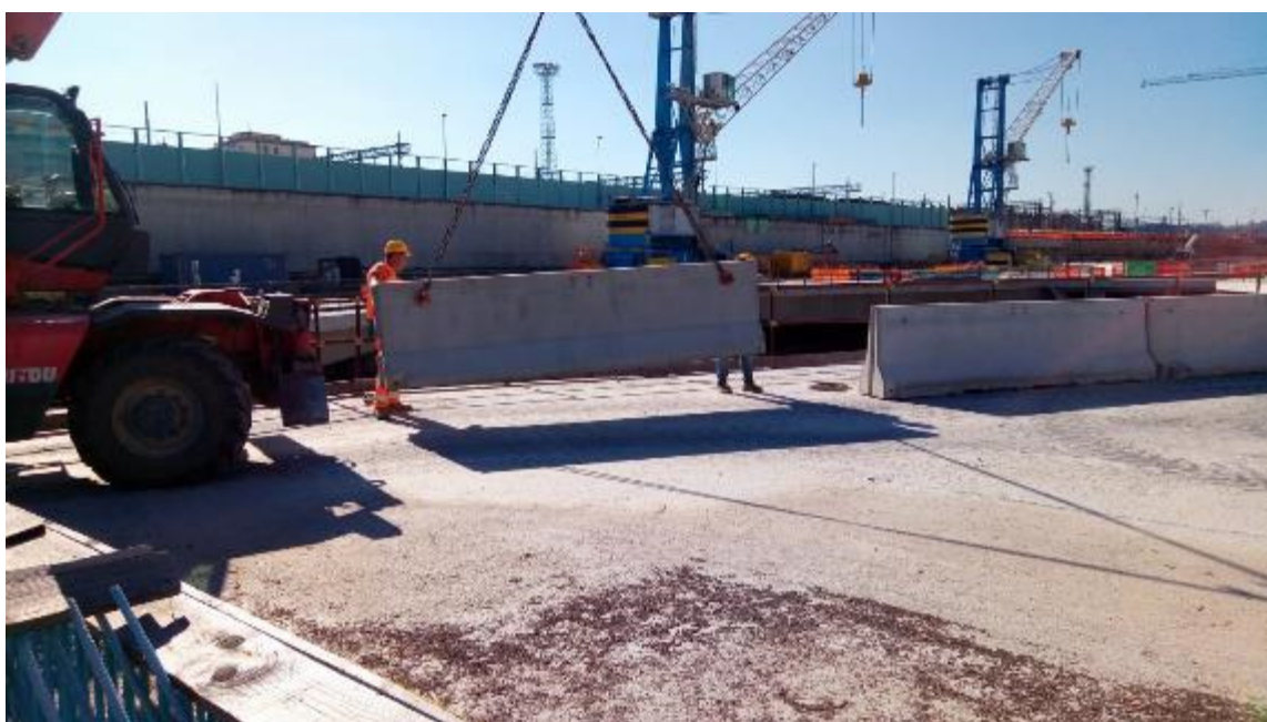
Foto 3 – Posa new jersey variante raccolta acque meteoriche
