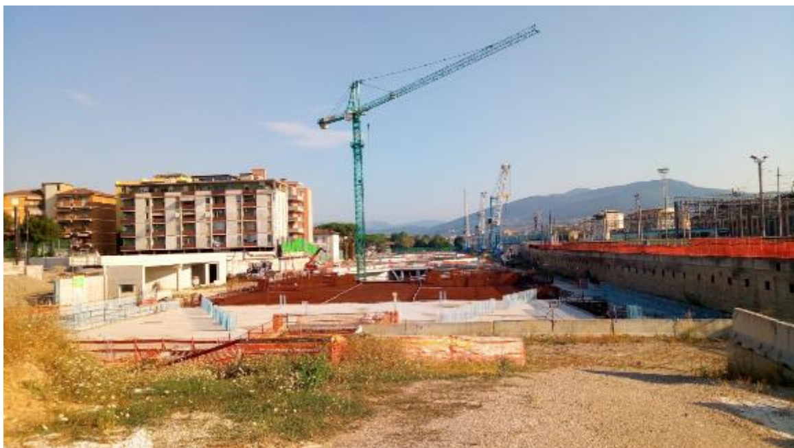
Foto 2 – Panoramica da Sud
