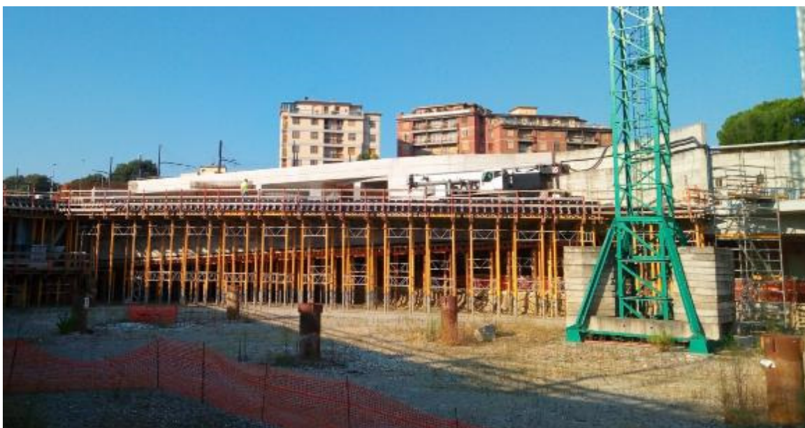
Foto 2 – Piazzamento autogru per smontaggio gru a torre "A"
