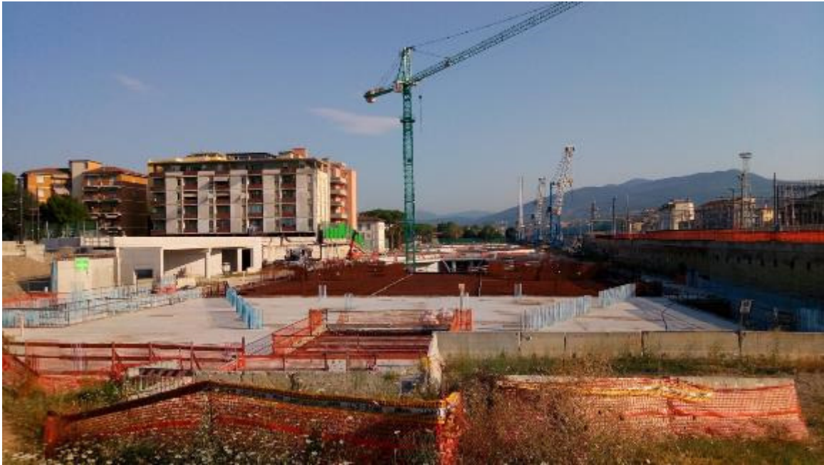
Foto 3 – Panoramica da Sud
