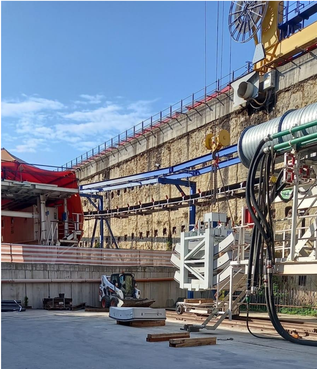
Figura 7- Scarico conchi su piattina per trasporto e installazione in galleria (CdM)
