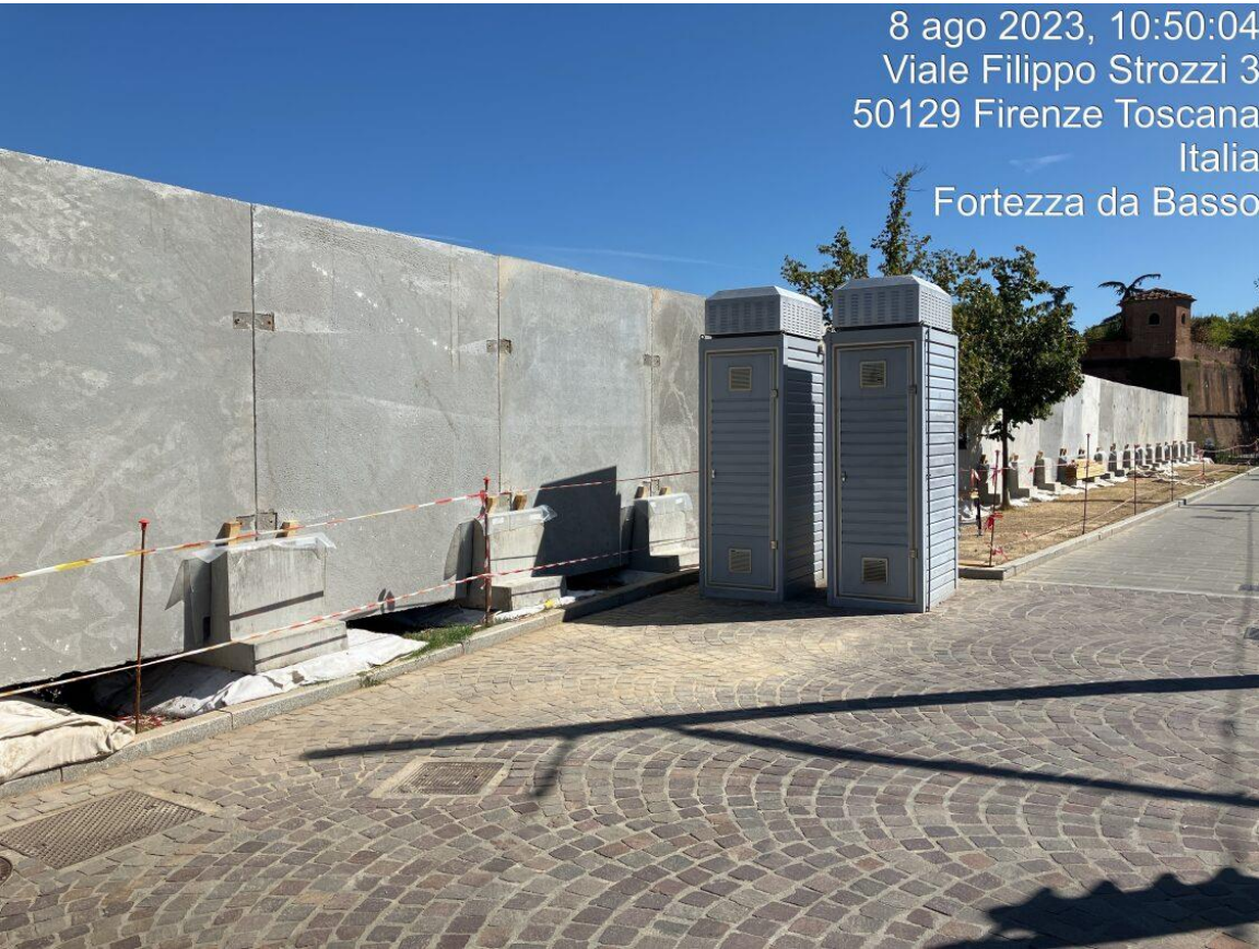
Figura 12 - Fortezza Area 2 - Attività di cantierizzazione – Barriere Antirumore
