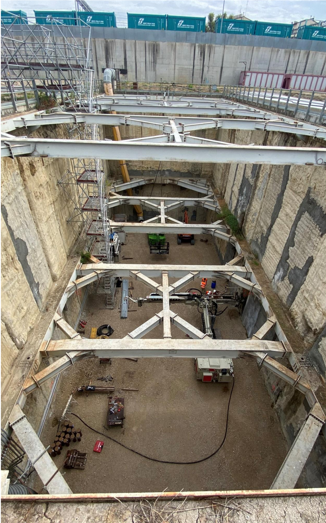
Figura 3 Pozzo Nord - Perforazioni
